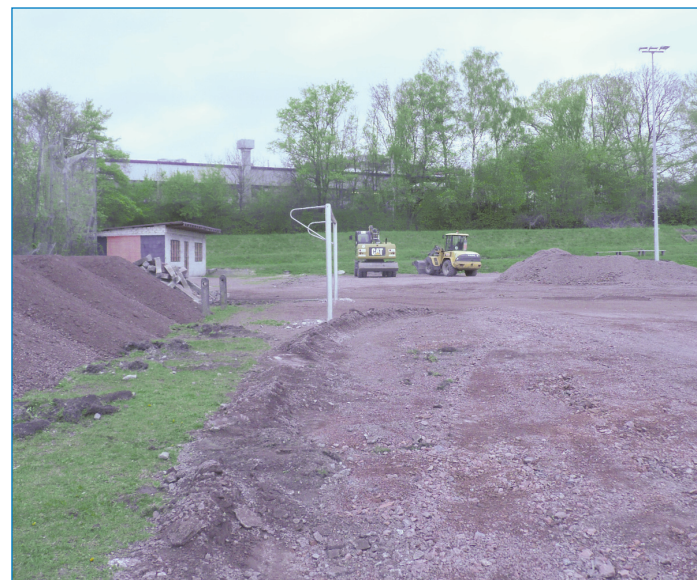
Der Oberflächenbelag ist bereits abgetragen. Foto: mh
