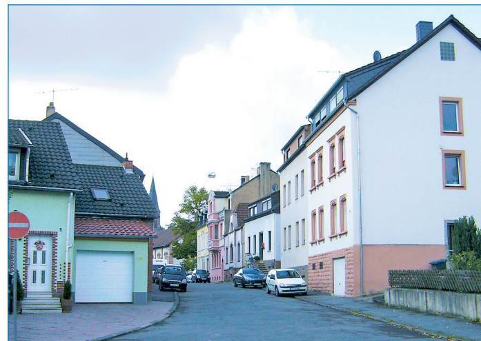
Wurden gefördert: Sanierungen im Stadtteil Wehrden
