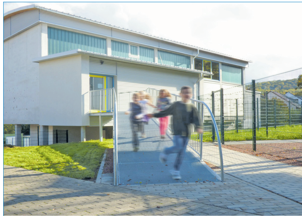
Der Notausgang wurde barrierefrei über eine Stahlrampe von der Straße Am Hasseleich an die Turnhalle angelegt. Rechts im Bild der mit Verbundsteinen gepflasterte Fußweg, der die Bachfeldstraße mit der Straße Am Hasseleich verbindet sowie die installierte Zaunanlage.
