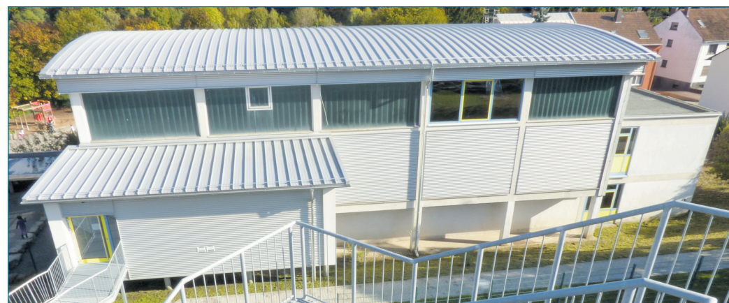
Der Geräteraum, der hier rechts im Bild als Flachdachgebäude zu sehen ist, erhält ein Pultdach. Fotos: bml
