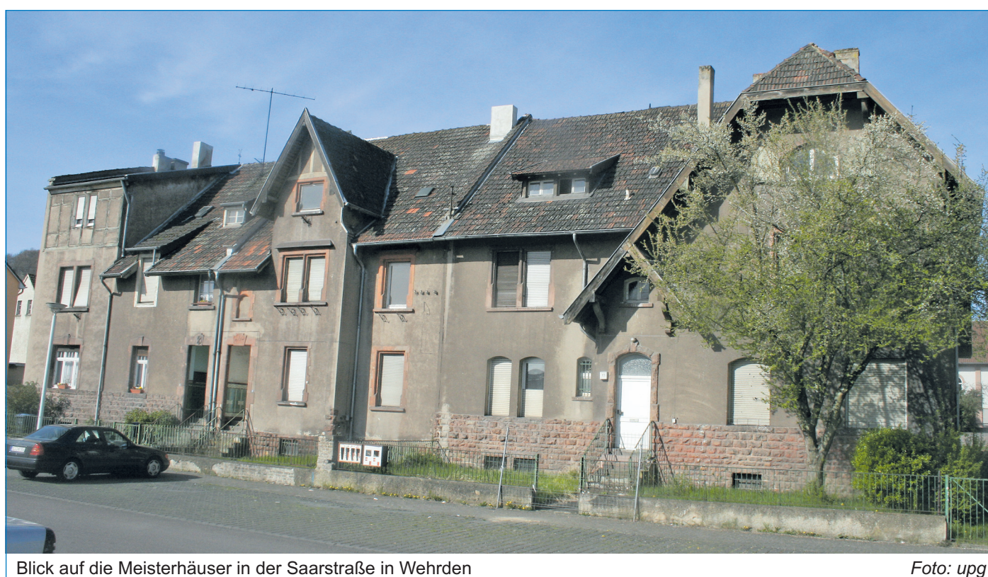
Blick auf die Meisterhäuser in der Saarstraße in Wehrden
